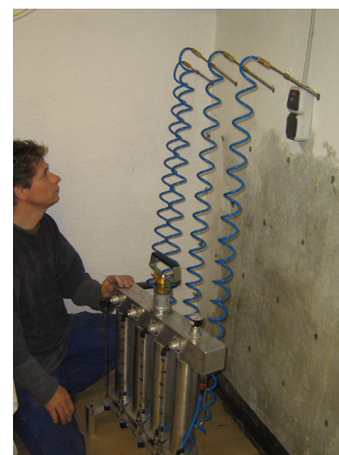
Bild 4 Maschinelle Injektion von Isophob K
